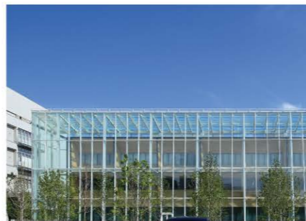
京三製作所 本社棟
