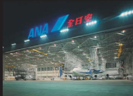
全日本空輸 成田国際空港 成田第1号格納庫 ANA Narita International Airport Hangar No.1
