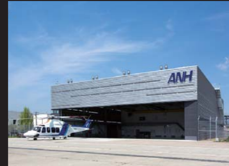
ANH 大阪基地新格納庫(監修業務) ANH Osaka Base New Hangar (Supervision)
