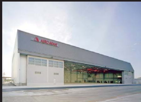
朝日航洋 名古屋小牧空港格納庫 Aero Asahi Nagoya Komaki Airport Hangar
