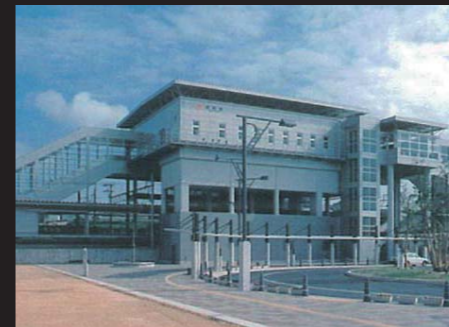
JR 愛野橋上駅 Aino Station
