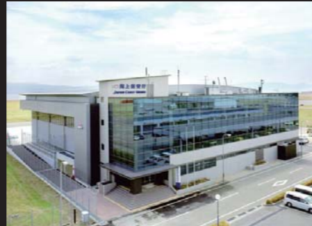
関西国際空港 海上保安航空基地格納庫 Kansai International Airport, Coast Guard Air Base Hangar
